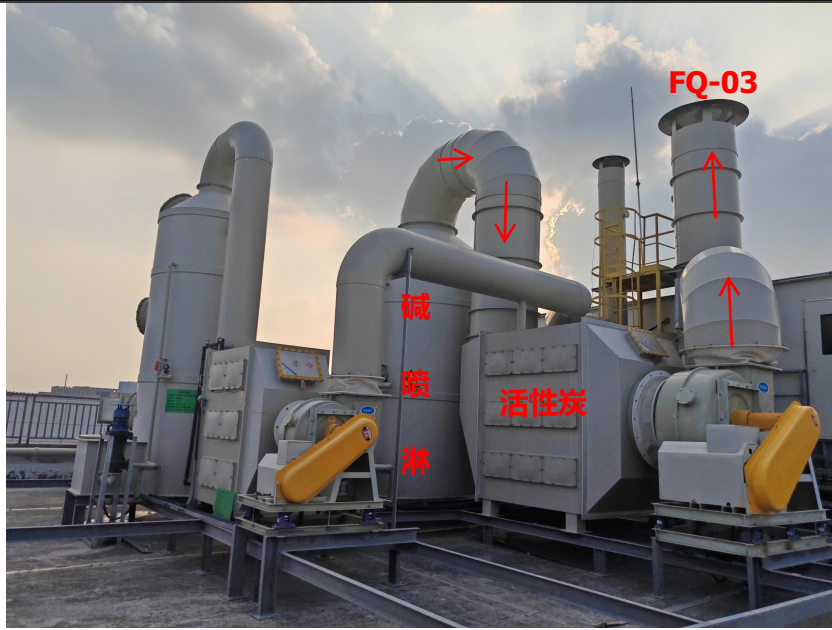
2楼另外部分废气处理设施及排气筒
