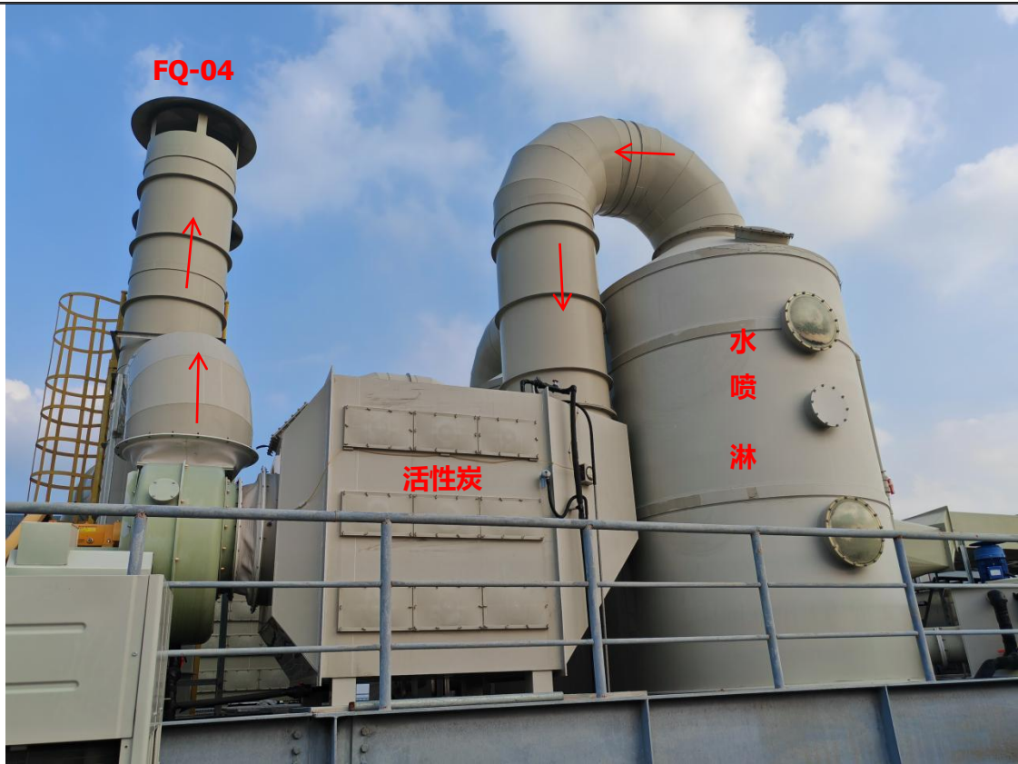
3楼废气处理设施及排气筒
