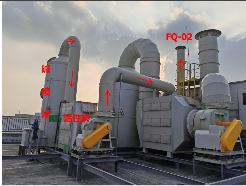
2楼部分废气处理设施及排气筒
