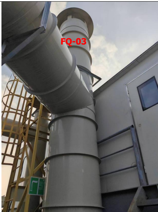
2楼另外部分废气处理设施及排气筒
