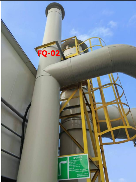
2楼部分废气处理设施及排气筒
