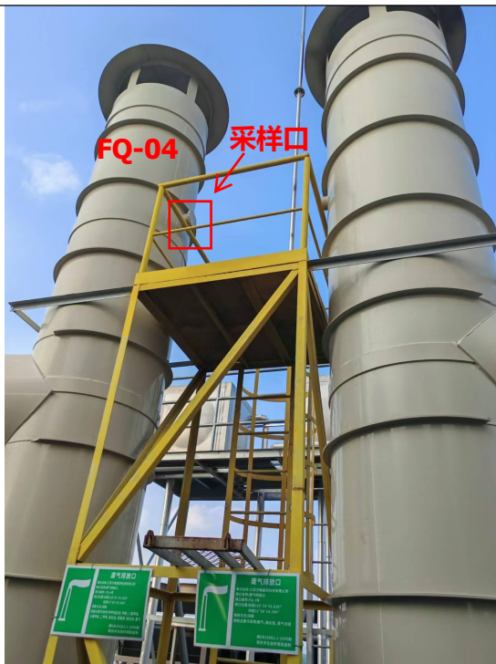
3楼废气处理设施及排气筒
